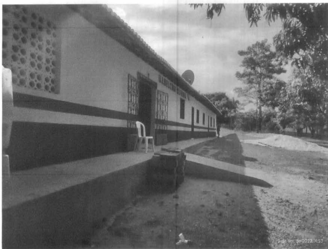
Imagem 4 – Serviços de recuperação de piso e Calçada
