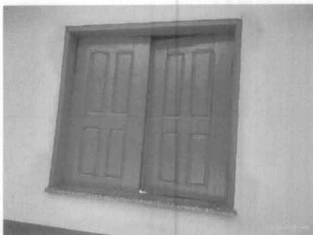
Imagem 2 – Serviços de Pintura de Esquadrias
