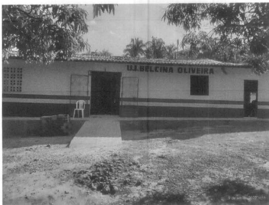
Imagem 1 – Serviços de Pintura e Recuperação de Telhado
