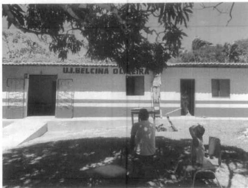
Imagem 3 – Serviços de pintura e recuperação de reboco
